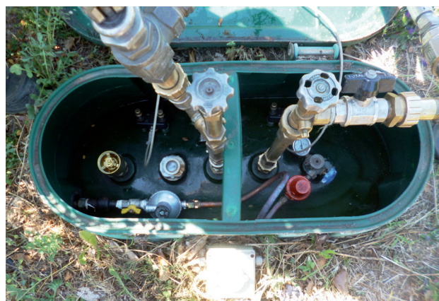
Collegamento delle manichette alle valvole fase liquida e gas durante il collaudo di un serbatoio
